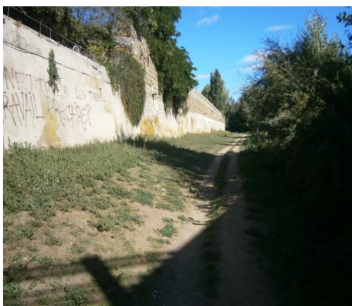
Chemin de halage le long de la collégiale
