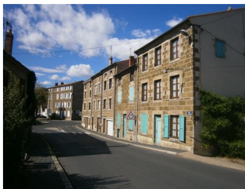
bâtiments à l'extrémité du pont
