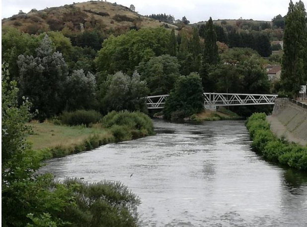
Passerelle reliant le centre-ville à la plaine de Von et à l'île d'Amour
